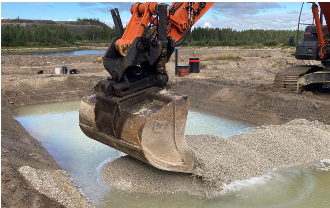
Kuva 47. Kalkkikivipadon asennustyötä.
