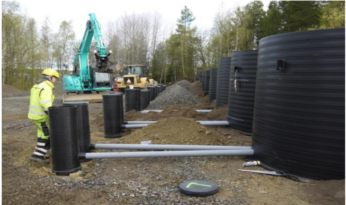
Kuva 4. Pilottirakenteiden asentamista Pyhäsalmealla.
