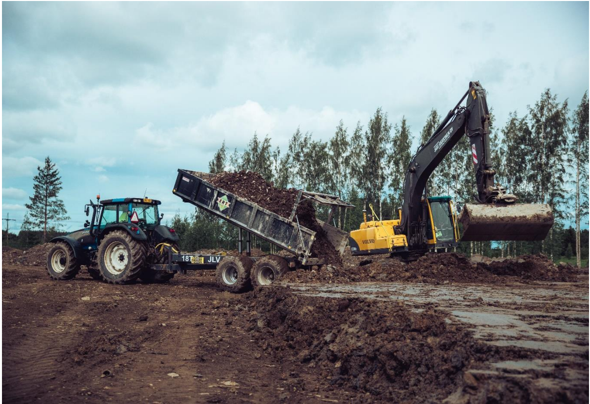
Kuva 39. Savipeitekerroksen rakentamista.
