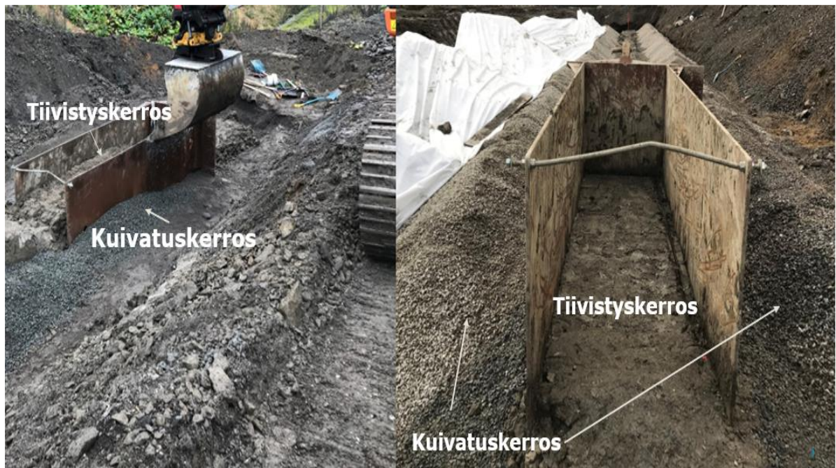
Kuva 36. Vasemmalla tiivistyskerroksen ensimmäinen kerros tuettuna kuivatuskerroksen materiaalilla, oikealla tiivistyskerroksen toisen kerroksen rakentaminen.
