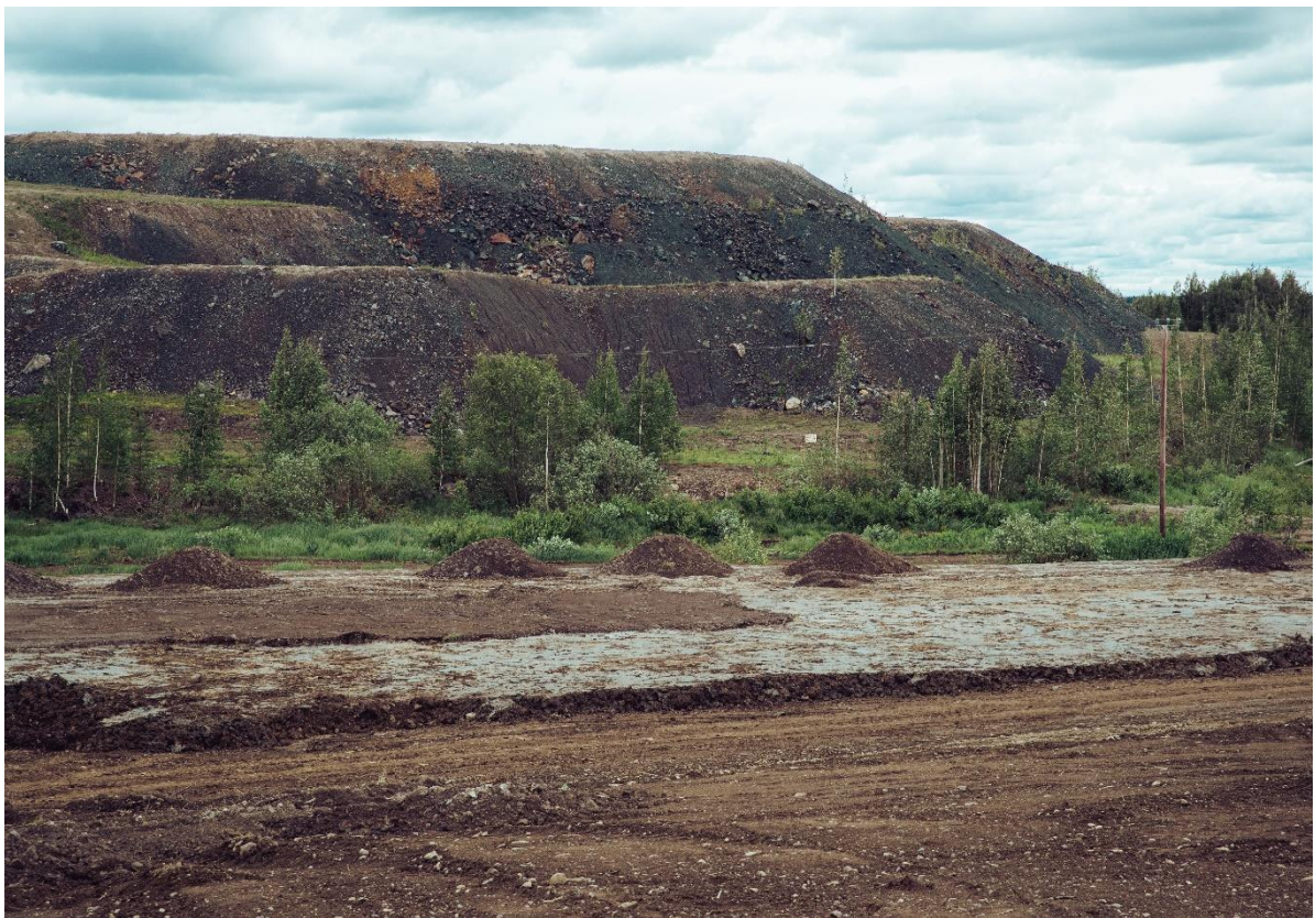
Kuva 40. Savipeitekerroksen rakennusvaiheet.
