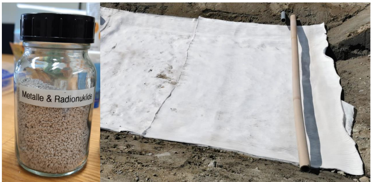
Kuva 45. Reaktiivinen mattorakenne (Hitura): vasemmalla maton sisältämää rakeista adsorbenttia ja oikealla matto asennettuna altaan pohjalle.
