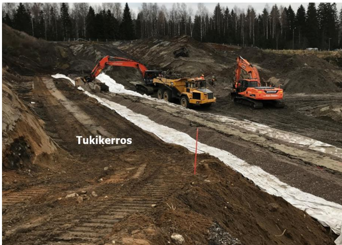
Kuva 37. Pystyeristysseinämän tukikerros.
