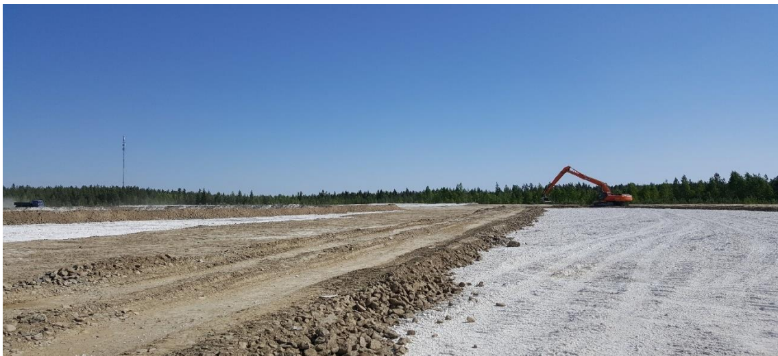
Kuva 32. Peittokerroksen rakentamista kuitusavella.
