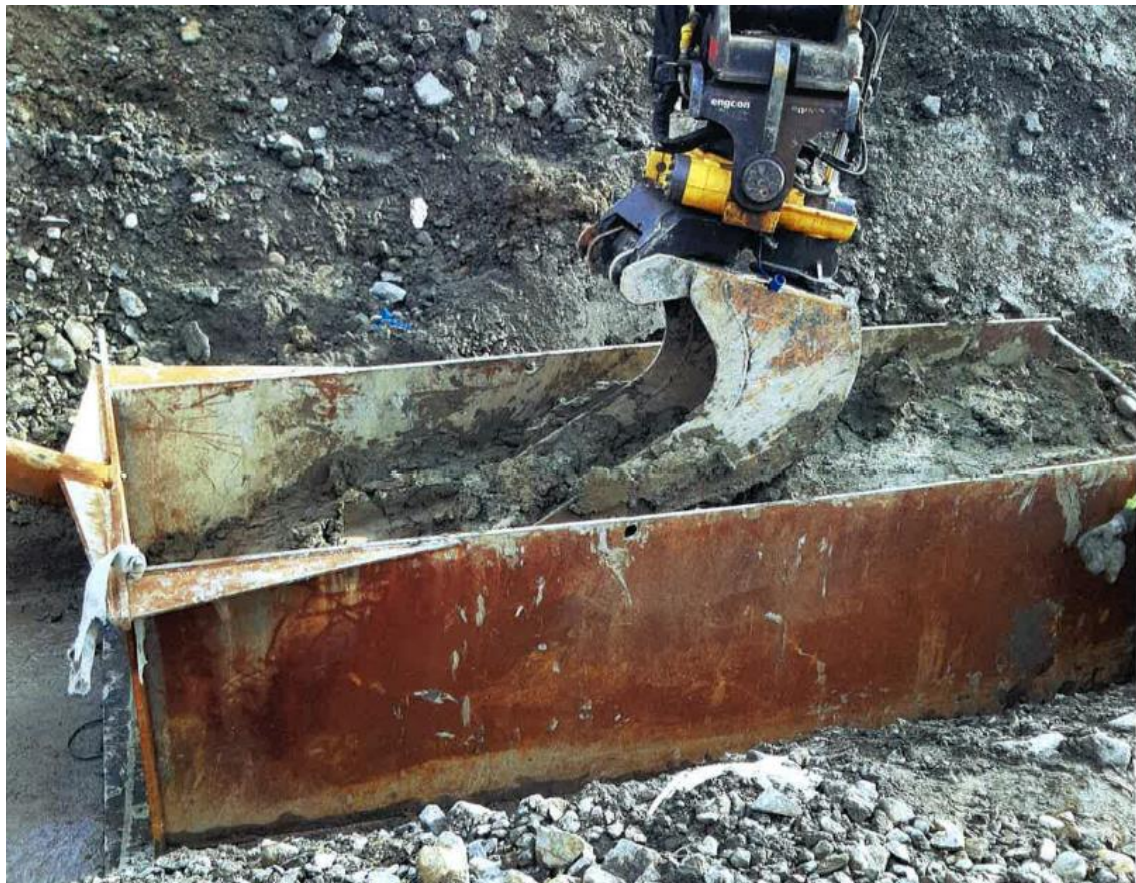
Kuva 35. Pystyeristeseinämän rakentamista muotilla.
